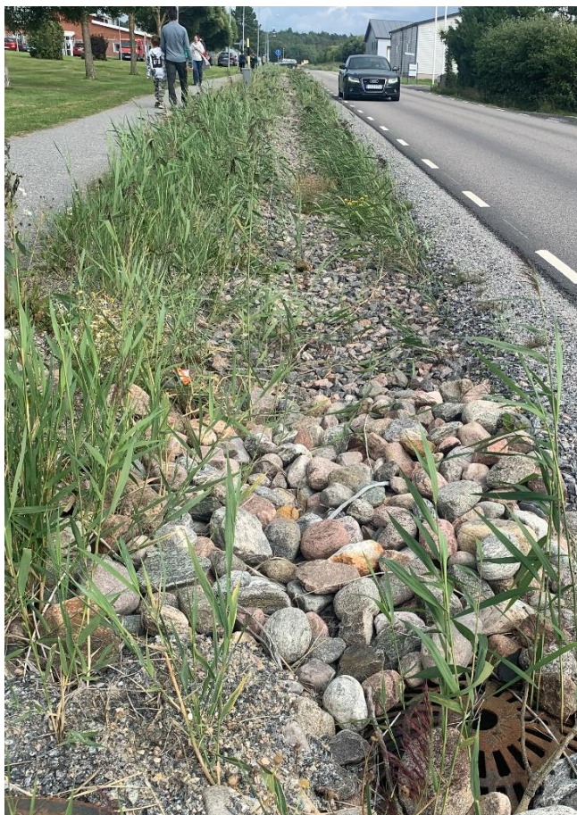
Figur 34. Exempel på växtbeklätt makadamdike längs väg. Foto: Sweco.
