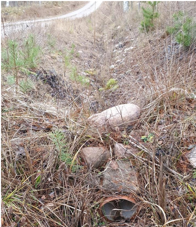
Figur 31. Bild på vägdike med strypt utlopp. Foto: Sweco.
