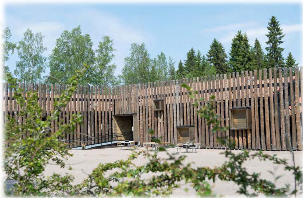
Bild: Torsby Finnskogscentrum i Lekvattnet med sin spektakulära fasad, ritat av Bornstein Lyckefors Arkitekter har utsetts till vinnare i WAN Awards 2016 och årets kulturpristagare 2017 av Wermländska Sällskapet i Stockholm.
