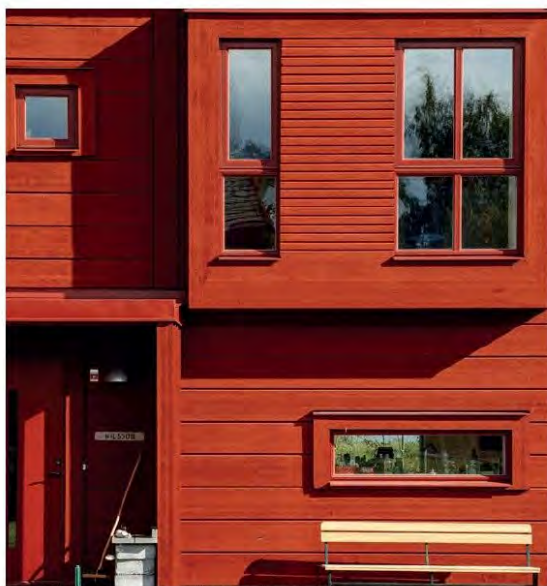
Villa, Rödön, ritat av Murman Arkitekter. Fasad utsnitt. Varierad och tredimensionell fasad med burspråk och kraftiga omfattningar. Den monokromt använda faluröda färgen håller ihop delarna och skapar ett modernt uttryck.
