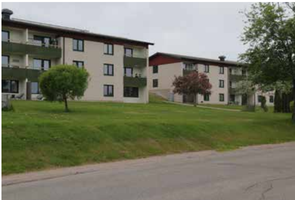
Bild 15. Hyreshus i Alstigen.
